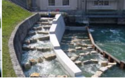
Die Fischtreppe wurde in 2008 komplett modernisiert.
