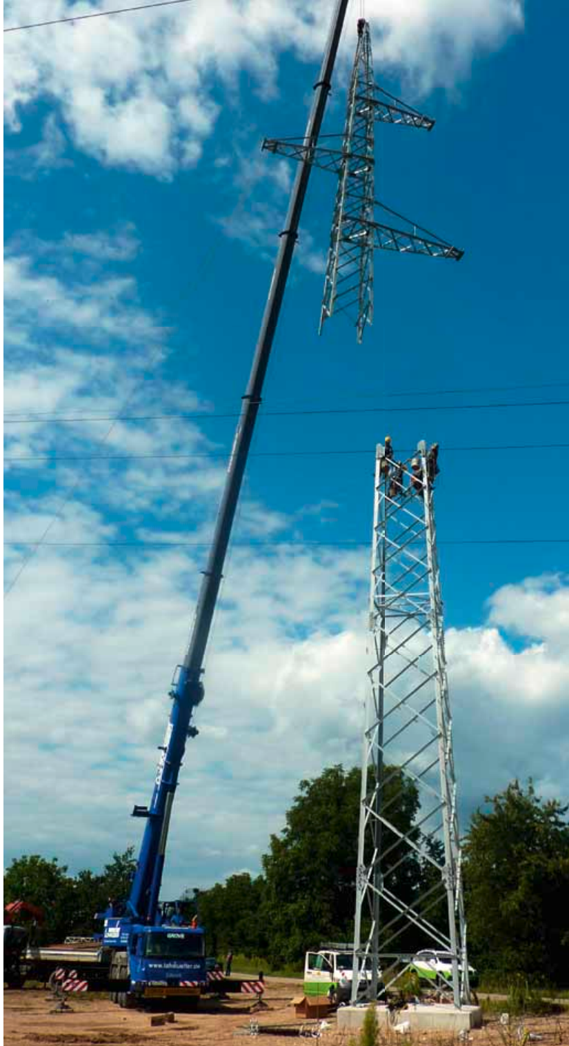
Die Energiedienst Netze GmbH ersetzt im Bereich der neuen Rheintalbahn auf der Gemarkung Weil am Rhein/Haltingen einen 110-kV-Stahlgittermast.
