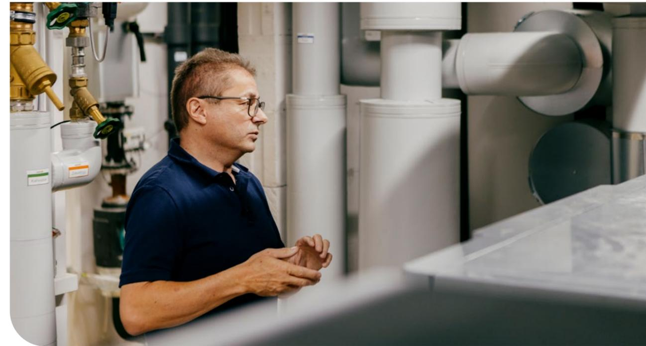
Die Gebäude werden durch reversiblen Wärmepumpenbetrieb auf Basis einer kalten Nahwärmeversorgung geheizt und gekühlt. Dazu wurden die Häuser an das von naturenergie in Schallstadt betriebene kalte Nahwärmenetz angeschlossen ( > mehr in der Infobox „Kalte Nahwärme in Schallstadt“). Dieses liefert Energie in Form von Wärme und Kälte. Diese Energie gewinnt naturenergie aus dem örtlichen unterirdisch verlaufenden Abwasserkanal, der einige hundert Meter vom Gebäude entfernt liegt.
