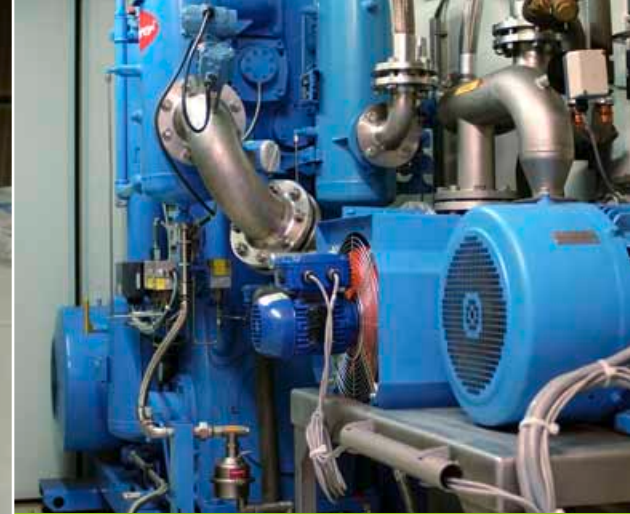
Bild oben: Im Maschinenraum pumpt der Kompressor das Gas unter Hochdruck zur Reinigung durch die Filter-Membrane.
